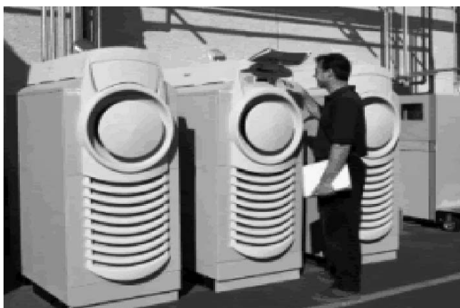
Rys. 10. Mikroturbina gazowa z katalitycznym spalaniem (Nawrat 2006)
