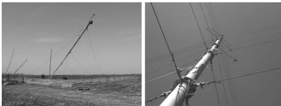
Rys. 1. Widok masztu pomiarowego w trakcie montażu dla lokalizacji (1) Źródło: Duraczyński 2008
